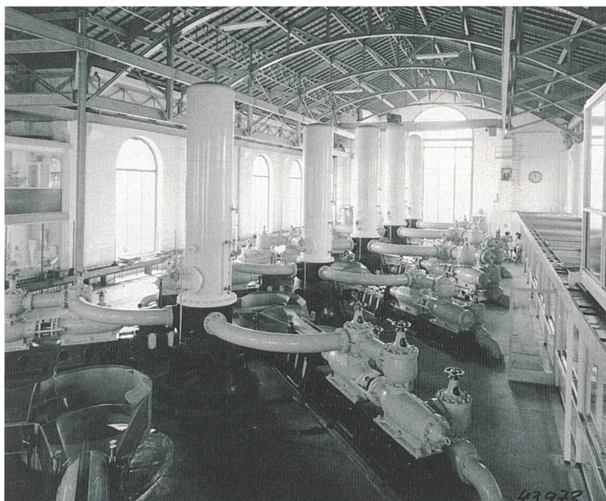
Photo 3 La salle des pompes de la centrale hydroélectrique, La Coulouvrenière, lors de son centenaire célébrée en 1986. Ces pompes étaient entraînées par des turbines Fontaine (type Jonval amélioré) construites par Escher Wyss
