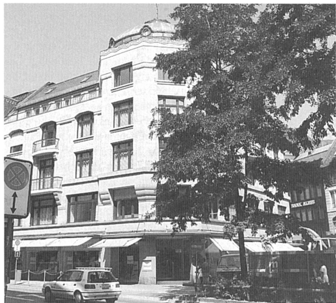
VSE-Büros in Zürich: 1. und 2. Etage, Bibliothek in der Kuppel. Der Eingang befindet sich rechts hinten um die Ecke
