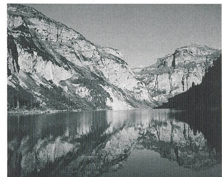
Bild 3 Neues Wasserkraftwerk: Ilanz II (Stufe Panix), hier der Panixersee
