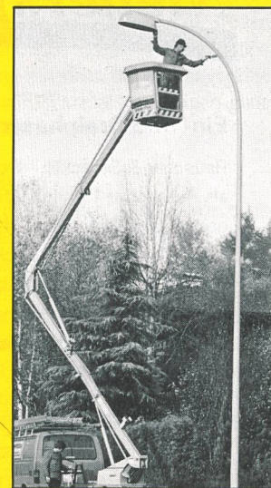
Korrosionsschutz an Stahlkandelabern
