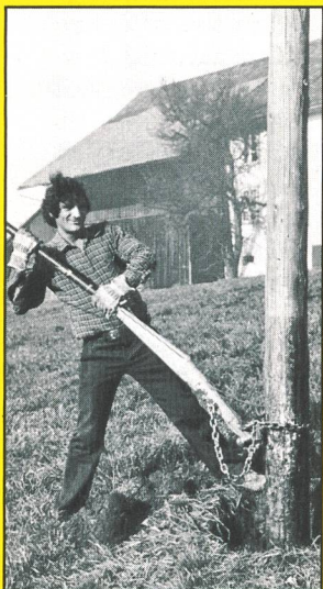
Nachimprägnierung von Holzmasten
