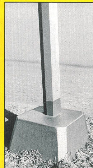
Betonschutz an Mastsockeln
