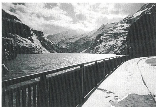
Speichersee Mauvoisin (VS): erhöhtes Rückhaltevermögen nach Staumauererhöhung
