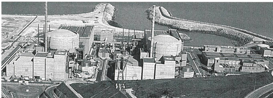
Bild 2 Neuestes französisches Kernkraftwerk: KKW Penly an der Steilküste der Normandie, dessen zweiter Reaktorblock 1330 MW leistet und am 1. November 1992 den kommerziellen Betrieb aufgenommen hat (Bild EdF)
