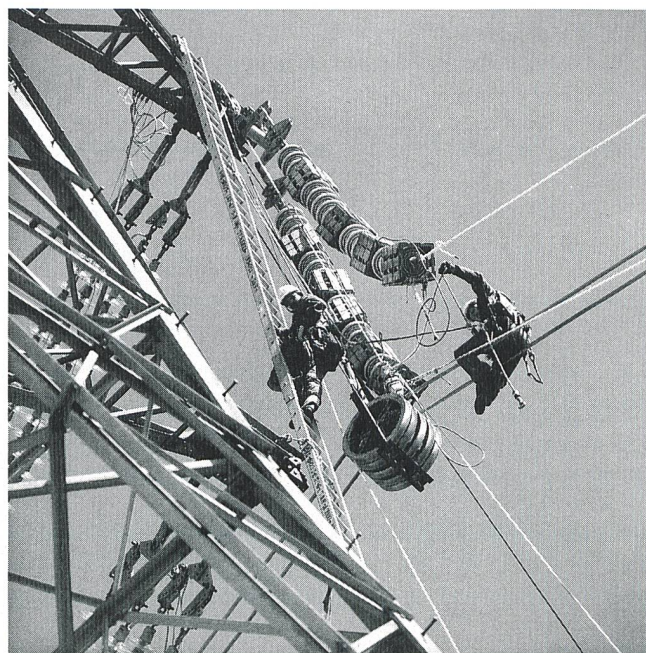
Figure 7 Installation d'isolateurs polymériques pour la ligne de 400 kV Deeside-Pentir
