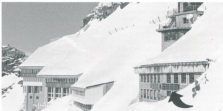
Bild 1 Flugaufnahme der höchstgelegenen netzgekoppelten Photovoltaikanlage der Welt, die seit Oktober 1993 an der Fassade der hochalpinen Forschungsstation Jungfraujoch in Betrieb steht. Links im Bild erkennt man das Restaurant Jungfraujoch (Foto Siemens)
