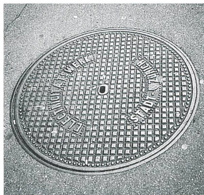
Bild 6 Dort wo sich unterirdische Kabelwege kreuzen, wurden einst die für den Kabelnachzug nötigen Schächte durch besondere, mit Elektrizitätswerk-Namen und Stadtwappen gekennzeichneten Gussdeckel, verschlossen (Zürich)
