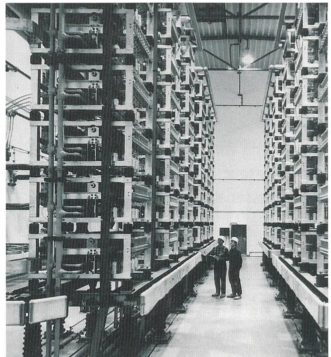
Zwölf haushohe Türme vollgepackt mit elektronischen Bauteilen verwandeln in der Gleichstrom-Kupplung Etzenricht den Drehstrom aus dem Versorgungsnetz einmal in Gleichstrom und wieder zurück. Nur mit diesem technischen Kniff können die beiden unterschiedlichen Stromnetze in West- und Osteuropa miteinander verbunden werden
