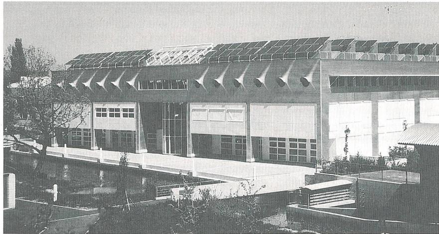
Bild 9 Ansicht des Neubaus Elektrotechnik mit 60-kW<sub>p</sub>-Photovoltaikanlage Solab 60
