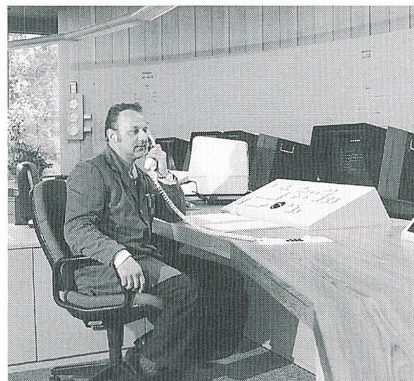
Bild 3 Die regionalen Netzleitstellen der NOK sind aufgrund eines speziellen Schaltprogramms in der Lage, das Ausserbetriebnehmen von unausgelasteten Transformatoren in eigener Regie vorzunehmen. Im Interesse der Netzsicherheit erfolgt vor dieser Massnahme jeweils eine Rückfrage an die zentrale Energie- und Netzleitstelle der NOK in Baden (Foto: NOK)
