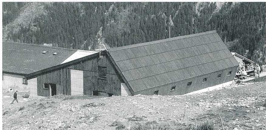
Bild 1 Photovoltaik-Anlage auf Alp Findels (erstes Solardach mit massgefertigten Photovoltaik-Ziegeln)
