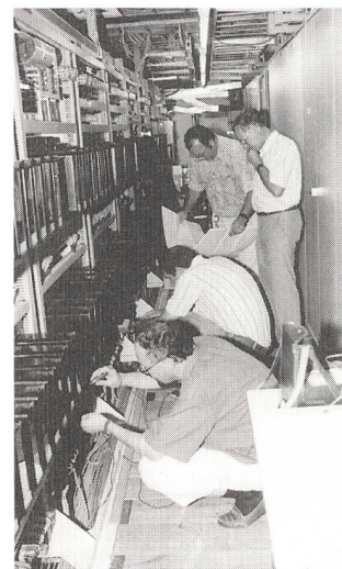
Montagekontrollen an Kabeln sowie Funktionskontrollen an Leittechnikgeräten gingen den eigentlichen Inbetriebsetzungstests des Notstandsystems des Kernkraftwerks Beznau voraus. Hier die Kontrollen im Elektroraum unter dem Kommandoraum des KKB II.
