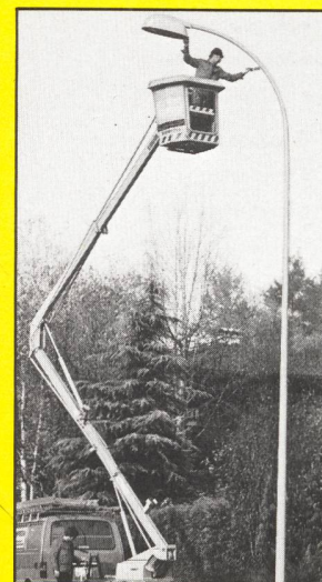
Korrosionsschutz an Stahlkandelabern
