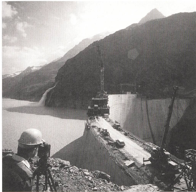
Erhöhung der Staumauer von Mauvoisin (VS) auf 250 m Höhe (1989–1991).
