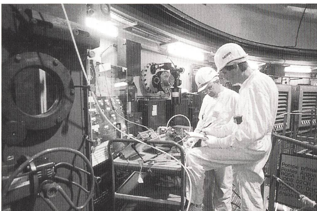
Untersuchungen im Reaktorgebäude des Superphénix.
