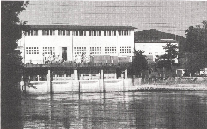
Wirkungsgradverbesserungen an Turbine und Generator des Kraftwerks Wildegg-Brugg erlauben künftig eine bessere Ausnützung der turbinieren Wassermenge.
