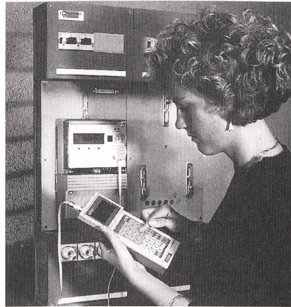
Bild 3 Zählerablesung mit Handterminal
