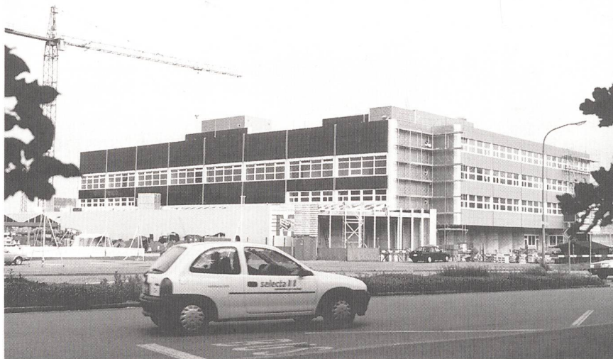
Die Solaranlage der Migros Winterthur verfügt über eine Leistung von 66,2 kW und erzeugt jährlich etwa 35 500 kWh Strom.
