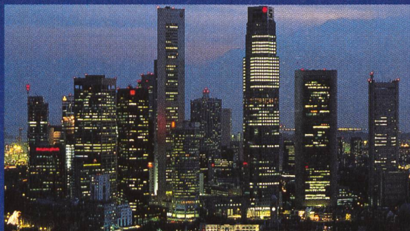
Singapur: Lieferung und Montage von Hochspannungskabeln
