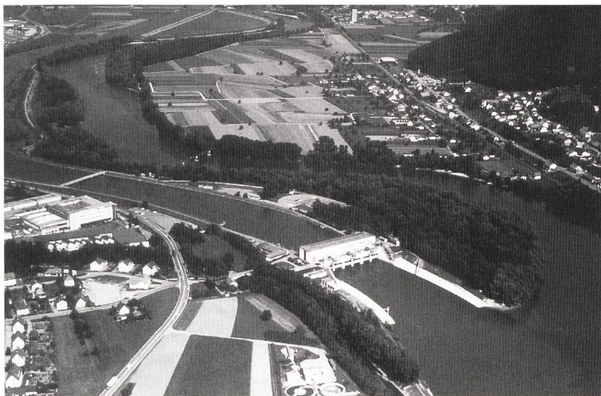
Im Stauwehr Dogern der Rheinkraftwerke Albbruck-Dogern soll eine Turbine eingebaut werden.
