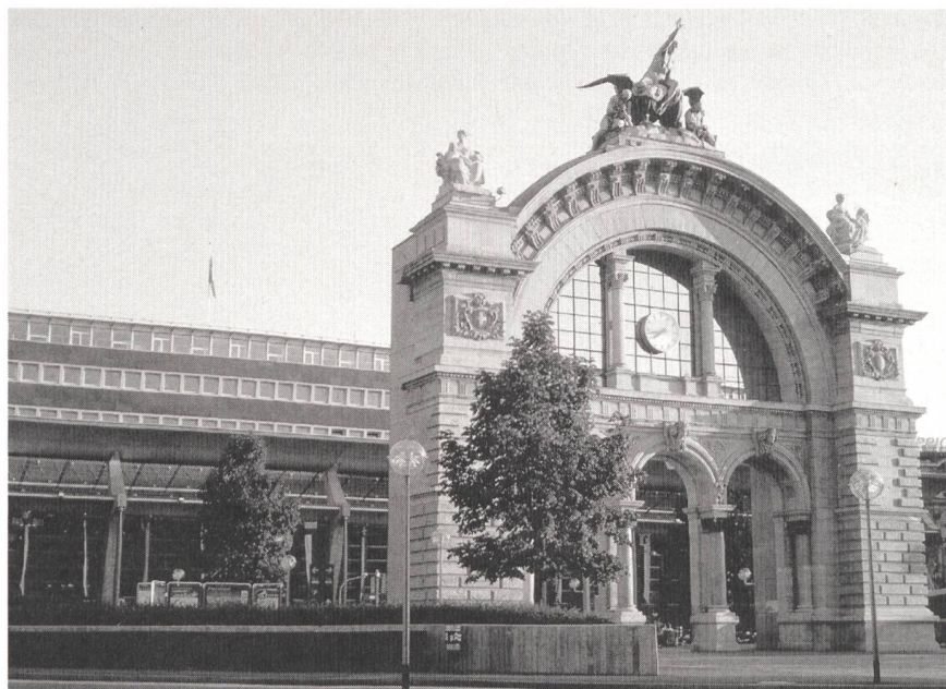
Innerhalb des Bahnhofs Luzern wird – auf dem Dach des Gewerbeschulzentrums – eine Photovoltaikanlage mit einer Spitzenleistung von 52,5 kW installiert (Foto: Tourist Information, Luzern).
