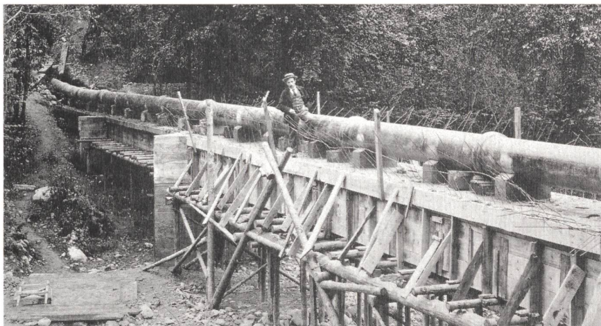
Conduite du Pays-d'Enhaut (1900).
