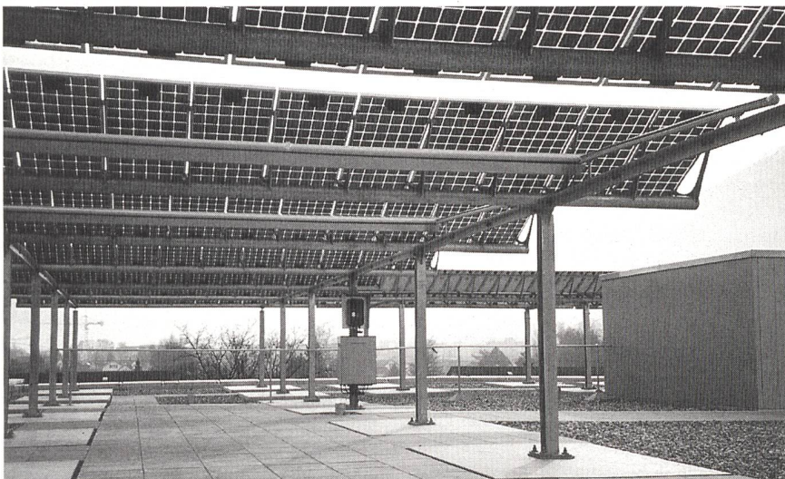
Bild 1 Die 20-kW p -Solarpergola am Neu-Technikum Buchs (Foto: Manfred Hagen).
