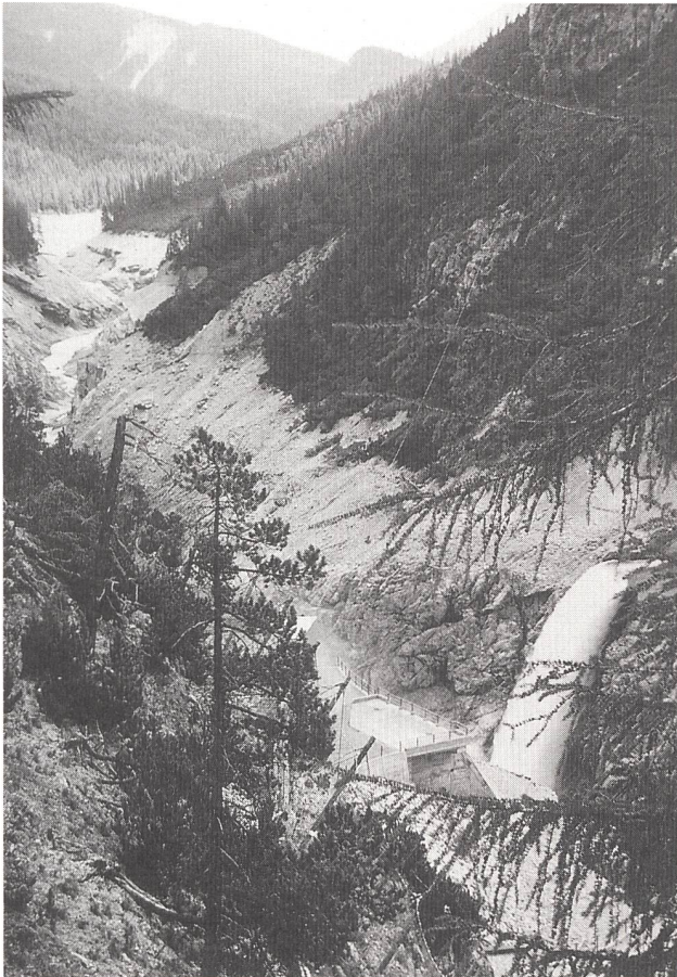
Bild 2 Entleertes Staubecken Ova Spin, das mitten in den Schweizerischen Nationalpark eingebettet ist. Das aus der Seewurzel zufließende Spülwasser wurde mit grosser Frischwassermenge, die über den Freispiegelstollen zugeleitet wurde, effizient verdünnt. Am rechten Bildrand ist die Mündung des Freispiegelstollens mit dem abstürzenden Innwasser ersichtlich.
