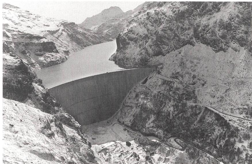
**Bild 3** Seit der Inbetriebnahme im Jahre 1956 sind im Stausee Mauvoisin etwa 10 Millionen Kubikmeter Stauvolumen verlandet.
