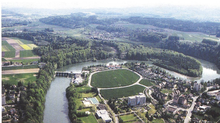
Wasserkraftwerke: hohe Energieernten (Kraftwerk Bremgarten-Zufikon).
