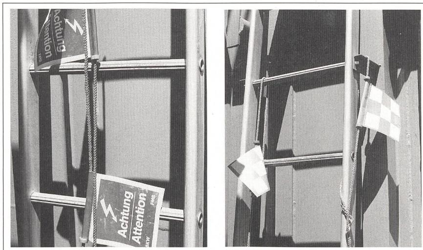
Bild 7 Temporär, während Routinewartung an den Aufstiegen von Grosstransformatoren angebrachte 2-Kriterien-Markierung.
