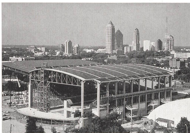
Das grösste dachintegrierte Solarkraftwerk der Welt auf dem Schwimmstadion in Atlanta (Foto: Solarex/Solarcenter Muntwyler).
