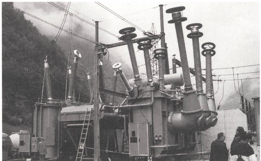
Bild 8 Vor-Ort-Diagnose-Prüfung an einem 220/380-kV-Netzkupplungstransformator, links: Regulierpol, rechts: Hauptpol bei der induzierten Spannungsprüfung.
