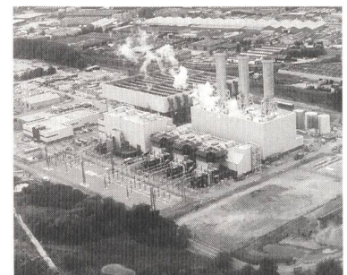
Das GUD-Kraftwerk Rye House ist bereits in Betrieb (Bild SI/KWU).
