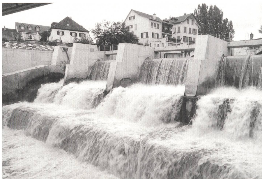
Das Kleinwasserkraftwerk Dornachbrugg wurde nach dreijähriger Bauzeit am 31. August in Betrieb genommen.
