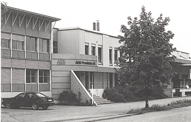
Der kundennahe Sitz der ABB Proelektra
