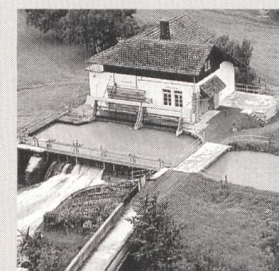
Kleinwasserkraftwerk Hürlimann an der Muota (SZ, 577 kW).
