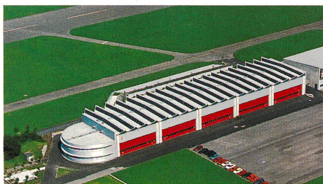
Shedintegrierte Photovoltaikanlage auf Montage- und Werkstattgebäude TH 89, Flugplatz Alpnach (Foto: Schweizer Flugwaffe)
