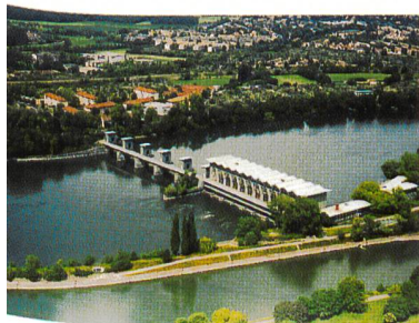
Renovation im Gange: Kraftwerk Birsfelden (BL)
