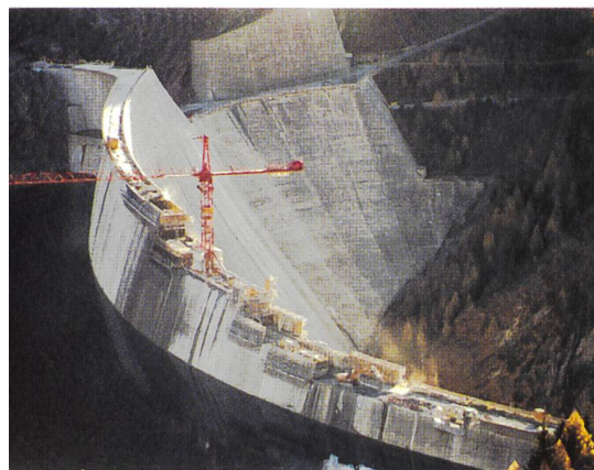
Die Staumauer von Luzzone (TI) wird gegenwärtig um 17 m erhöht. Damit ist eine Verlagerung von 60 GWh vom Sommer auf den Winter möglich.
