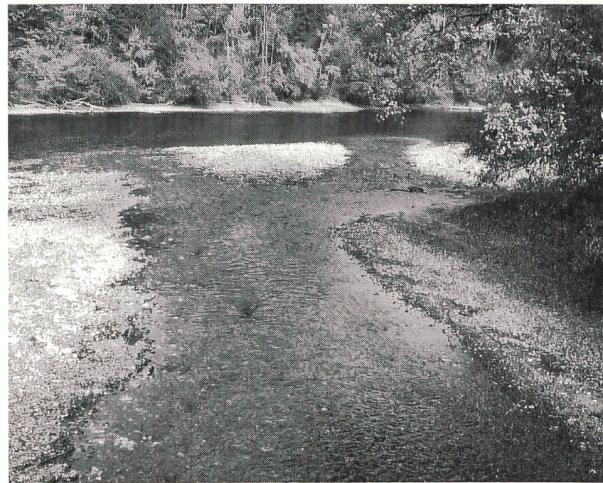
Geschiebe soll wieder bis in die Aare gelangen können – wie hier an der Mündung der Murg. Dies führt zu betrieblichen Problemen und Produktionseinbussen bei den Aarekraftwerken.
