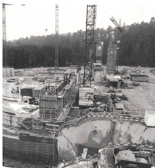
Die Baustelle Zwilag in Würenlingen Mitte Dezember 1996. Um das Jahr 2000 soll die Anlage gestaffelt in Betrieb genommen werden.
