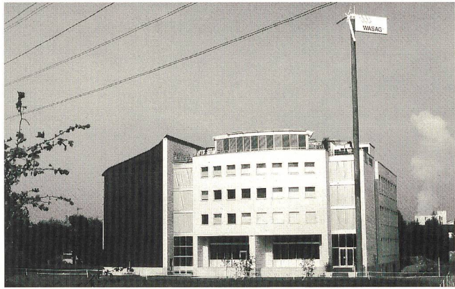
In Oberentfelden AG steht dieser zukunftsweisende Industrieneubau der Wasag Bürstentechnologie. Über die Hälfte des Bruttowärmebedarfes in diesem Neubau wird durch Abwärme und durch in der Solarwall (links im Bild) erwärmte Aussenluft gedeckt. (Fotos: Wasag)
