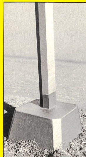
Betonschutz an Mastsockeln
