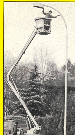
Korrosionsschutz an Stahlkandelabern
