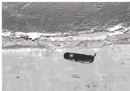
Weisse Salzkruste hinter abgesprengten Betonsplittern (Bild EMPA).
