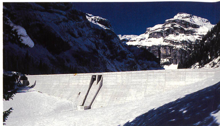
Wasserkraft als wichtigste einheimische und erneuerbare Energiequelle: Stauanlage Panixersee (GR).
