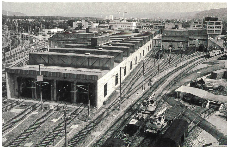
Bild 1 Aussenansicht des neuen Lokdepots Basel für die «Bahn 2000» mit Betriebsremise (links oben), Pendelzughalle (Vordergrund), Werkstattremise und Dieselwerkstätte sowie Bürogebäude (rechts oben). Dieser Gebäudekomplex weist nicht nur in bahntechnischer Hinsicht ein zukunftsgerichtetes Konzept auf, sondern verfügt vor allem auch bezüglich der Beleuchtungstechnik, das heisst bei der Lichtsteuerung, über eine unkonventionelle Lösung. (Fotos: Carlo Gavazzi AG)
