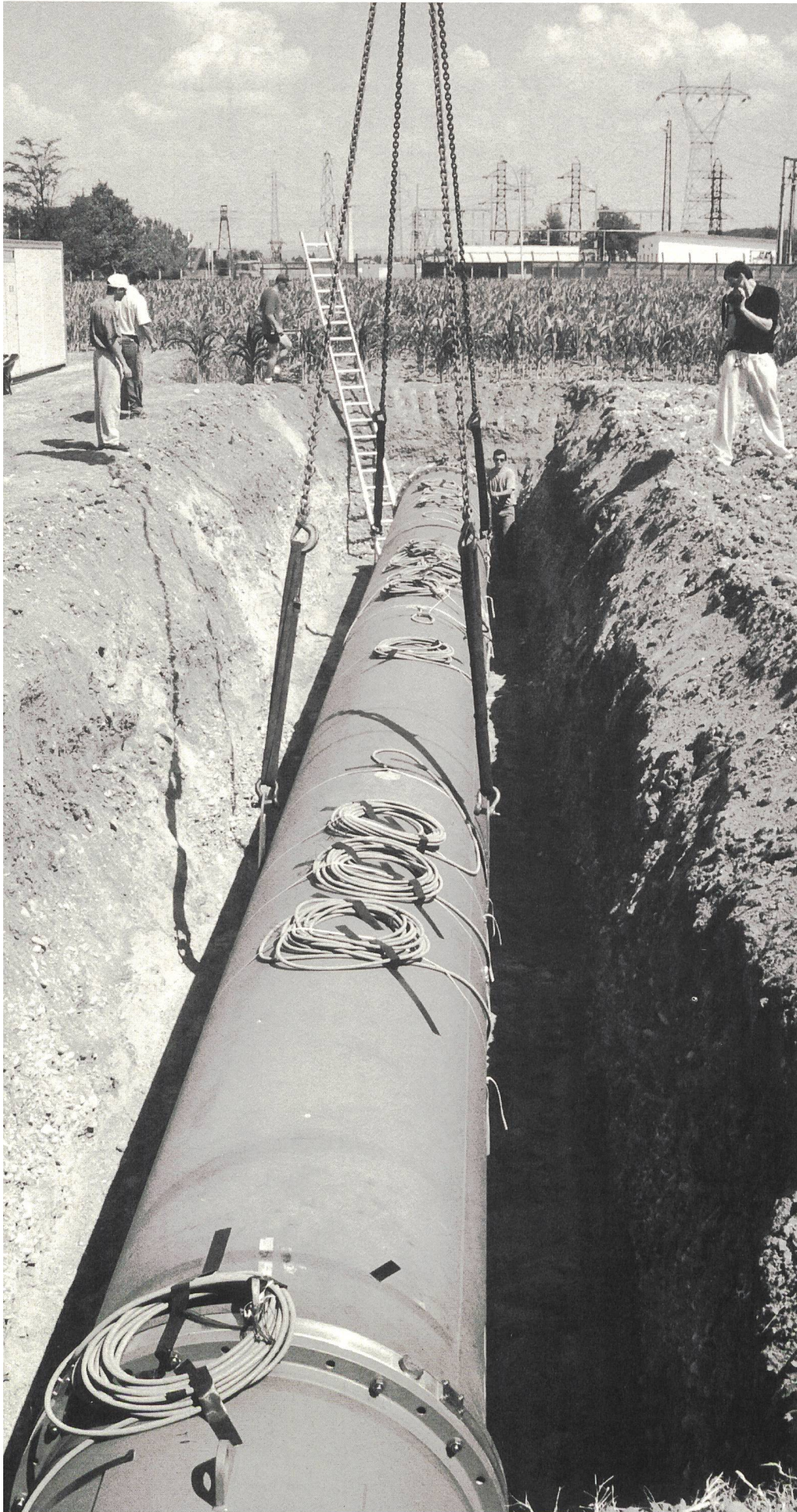
Bild 1 Strom aus der Pipeline: Dieses System reduziert die Gesamtgrösse und die Kosten eines unterirdischen Stromübertragungssystems.
