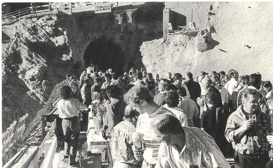
Im Bleniotal wurde gefeiert: die Bauleute feierten den Abschluss der wichtigsten Etappe. Die Staumauer ist nun 17 Meter höher. In einem Jahr sollen sämtliche Arbeiten wie Ausfugen und Strassenarbeiten abgeschlossen sein.
