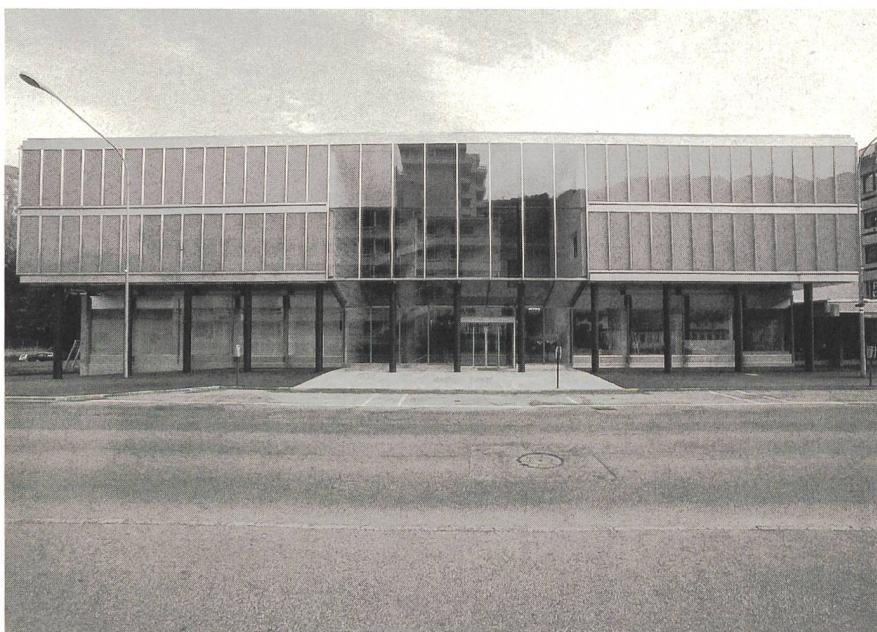
Das neue Verwaltungsgebäude der EWBO. Die Kombination von Glas und Chromstahlprofilen soll das Gebäude filigran und transparent erscheinen lassen.
