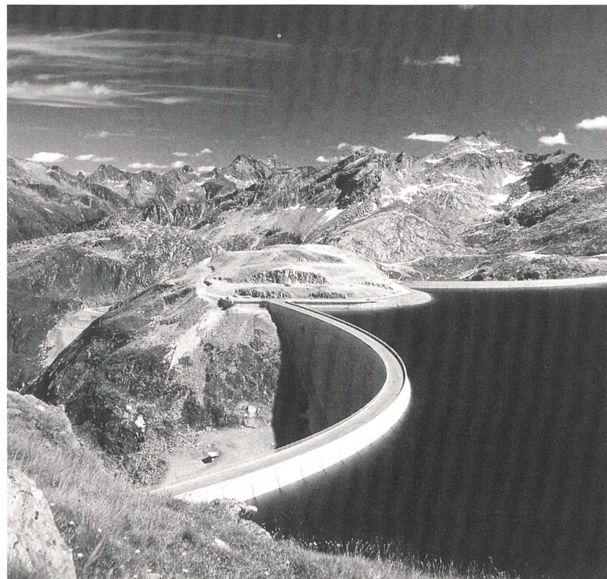
Zwei Bogenstaumauern für einen See: Naret I und II (TI). Dieses Unikum ist von allen Blickwinkeln her gesehen spannend und interessant (Bild Ofima).
