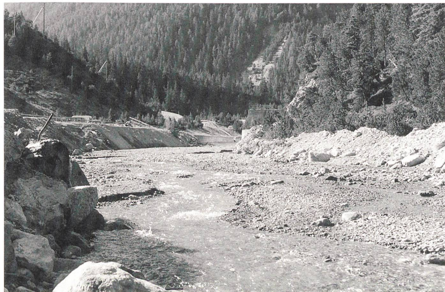
Vue 200 m en dessous de la prise d'eau Clemgia/Inn des Forces motrices de l'Engadine SA: sans cession de débit résiduel, uniquement avec écoulement naturel (vue prise le 15 août 1997). Le débit résiduel proposé dans le cadre de l'assainissement s'élève à 1 m 3 /s aux mois de juillet et août.
