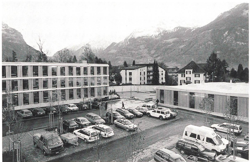
Die neuerstellten Gebäude des EWA auf dem Areal «Eselmätteli» konnten im Juli 1997 bezogen werden. Gegen 90% der Bauarbeiten wurden an Bauunternehmungen im Kanton Uri vergeben.
