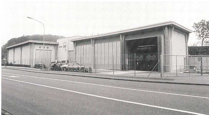
Wegen der engen Platzverhältnisse zieht sich das Unterwerk Balsberg in die Länge. Rechts die zwei Transformatoreneinheiten 110/16 kV, deren Abwärme für die Gebäudeheizung abgezeigt wird.
