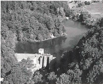
Le barrage et le lac de l'Aubonne: la modernisation des installations augmente le débit à 10 m<sup>3</sup>/s. La production annuelle est estimée à 42,2 mio de kWh. Photo: IPV, L. Dubois
