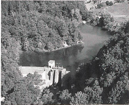
Le barrage et le lac de l'Aubonne: la modernisation des installations augmente le débit à 10 m 3 /s. La production annuelle est estimée à 42,2 mio de kWh. Photo: IPV, L. Dubois
