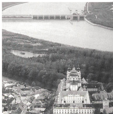
72% Wasserkraft in Österreich (Donaukraftwerk Melk, Bild Verbund).
